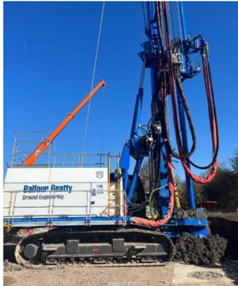
Casagrande Piling Rig
